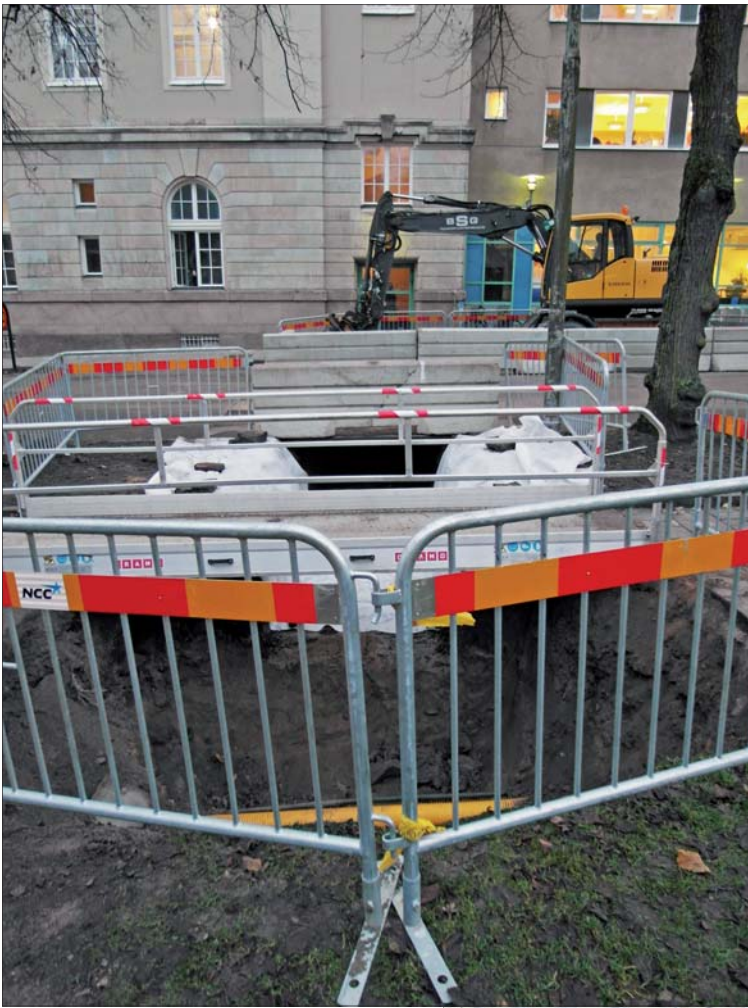
Figur 4. Schaktningen sedd från norr mot Kungsgatan 20. Foto Mats Magnusson, Östergötlands museum.
