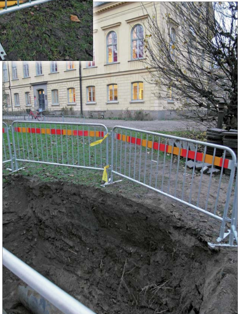
Figur 5. Stamledningen för fjärrkyla som lades ner vintern 2001/2002 framschaktad i oktober 2013. I schaktets norra vägg finns bevarade kultur-/odlingslager och i bakgrunden syns Gamla Tingshuset/Ljungstedtska friskolan som uppfördes vid mitten av 1800-talet. Foto Mats Magnusson, Östergötlands museum.
