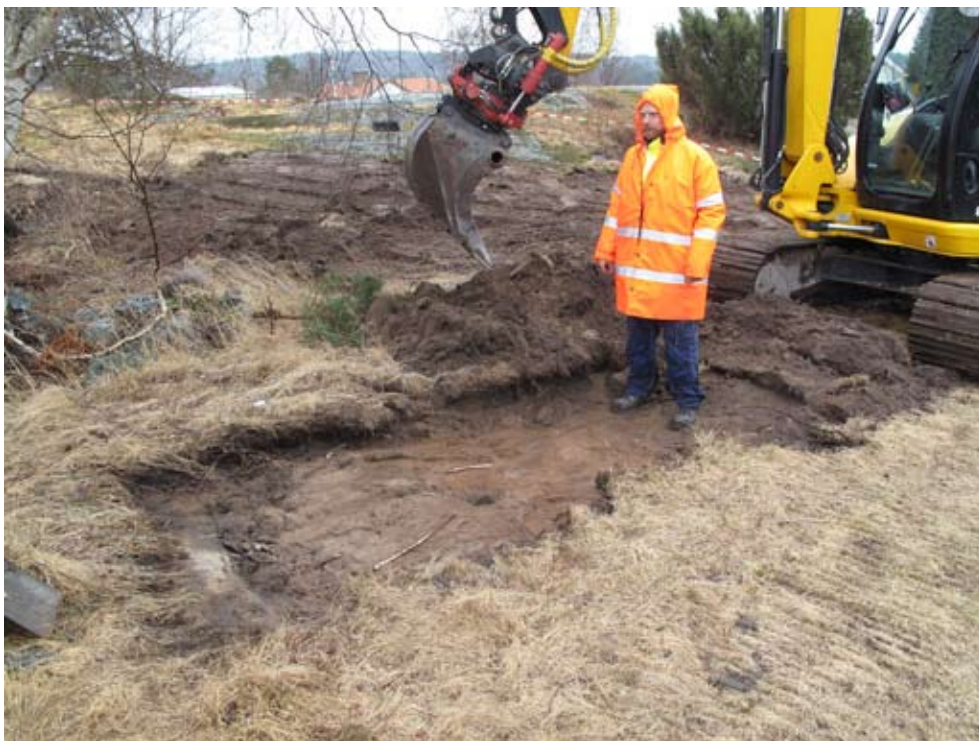
Figur 4. Grävmaskin användes vid förundersökningen. Här ses arkeolog Tom Wennberg kontrollera ett schakt.
