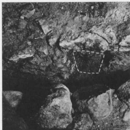
Parti av stavrännan till stavkyrkan i Silte. I kallmuren finns ett urtag där den tvärgående bjälkens ände är synlig. Bjälkens ungefärliga, ursprungliga tjocklek har markerats med vitt. Foto G. Trotzig. — Part of the stave groove in the stave church at Silte. There is a recess in the dry wall, where the end of a transverse beam can be seen. The approximate original thickness of the beam is marked in white.
